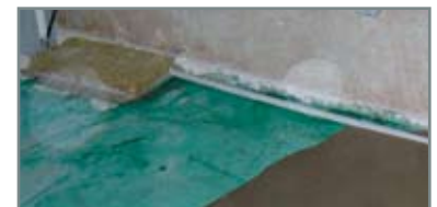
Application of primer
